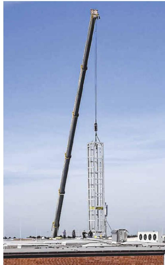
Die Montage des Vertikalförderers erfolgte über eine kleine Öffnung im Dach und wurde binnen weniger Stunden durchgeführt.
